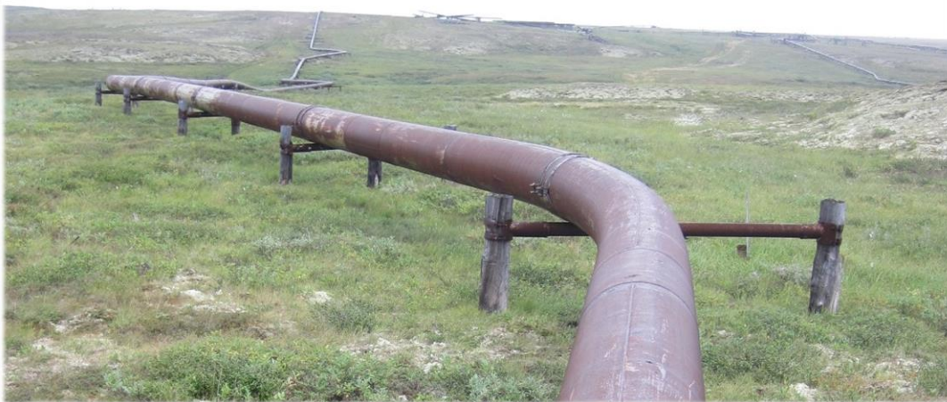
Рис. 1. Общий вид трубопровода
